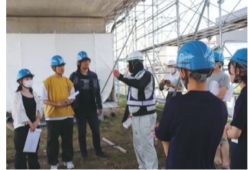
建設現場見学会
